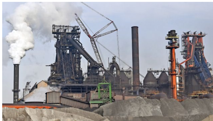
Hoogovens van ArcelorMittal Gent waarvan één vervangen zal worden door een DRI-installatie op basis van waterstof
