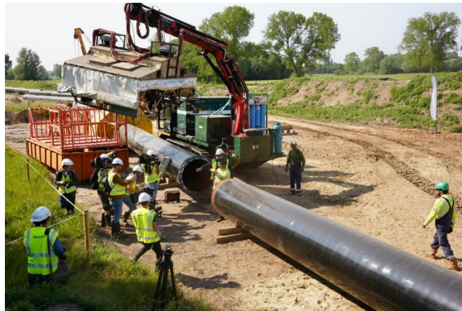
Constructiewerken waar de eerste waterstofpijpleidingen de grond in gaan
