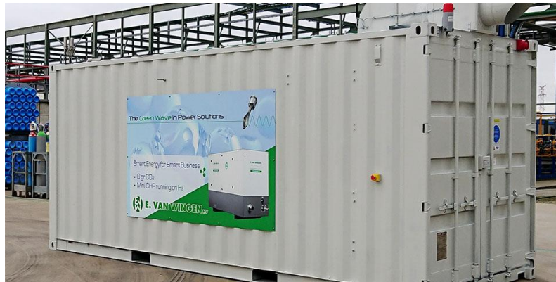
Figuur 28: WKK op waterstof van E. Van Wingen 36
